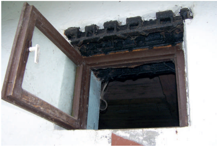
Il. 167 Ogniwo od czołgu Tygrys II, wbudowane w okno, Lisów 2015 r.
