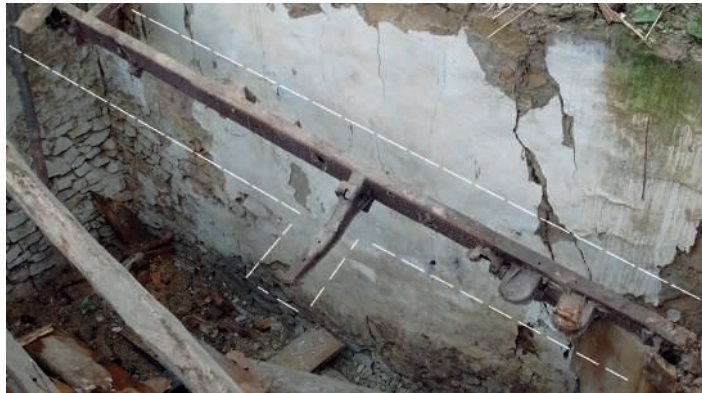
Il. 243 Fragmenty rami od niemieckiego samochodu wojskowego Horch, wykorzystane jako sklepienie piwnicy.
