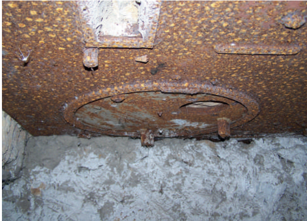
Il. 217 Płyta pancerna z włazem jako strop piwnicy, 2013 r.
