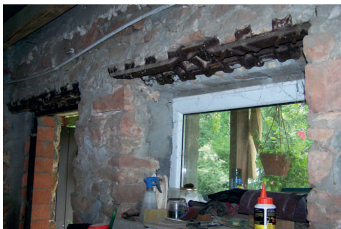
Il. 179 Ogniwa od czołgu Pantera, wbudowane w okno i nadproże, Radomice 2015 r.
