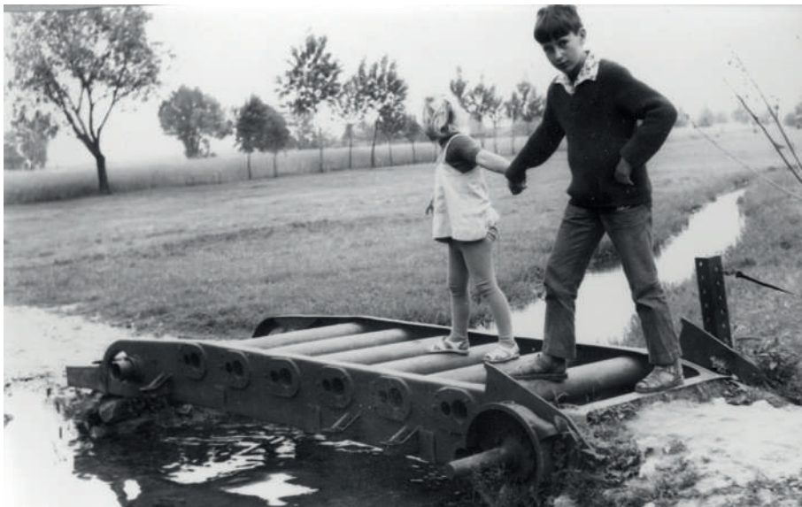
Il. 235 – Mostek wykonany z ramy od transportera Sd.Kfz.251, Chałupki Zbrzańskie 1968 r.
