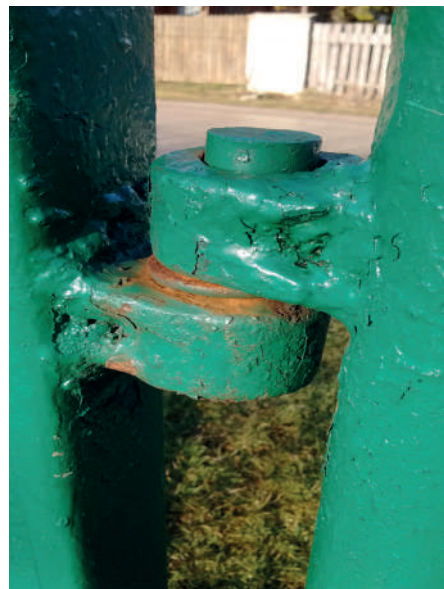
Il. 172 – Fragmenty ogniwa od czołgu Tygrys II wykorzystane jako zawiasy, Obice 2019 r.
