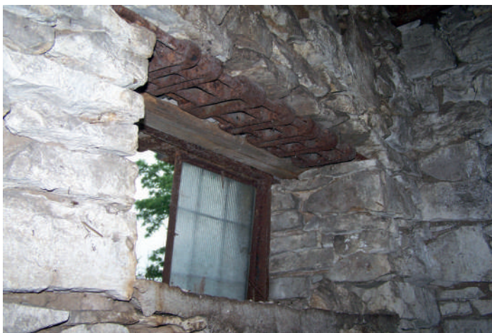
Il. 163 Ogniwo gąsienicy od czołgu Tygrys II wykorzystane przy budowie otworu okiennego, Lisów 2014 r.
