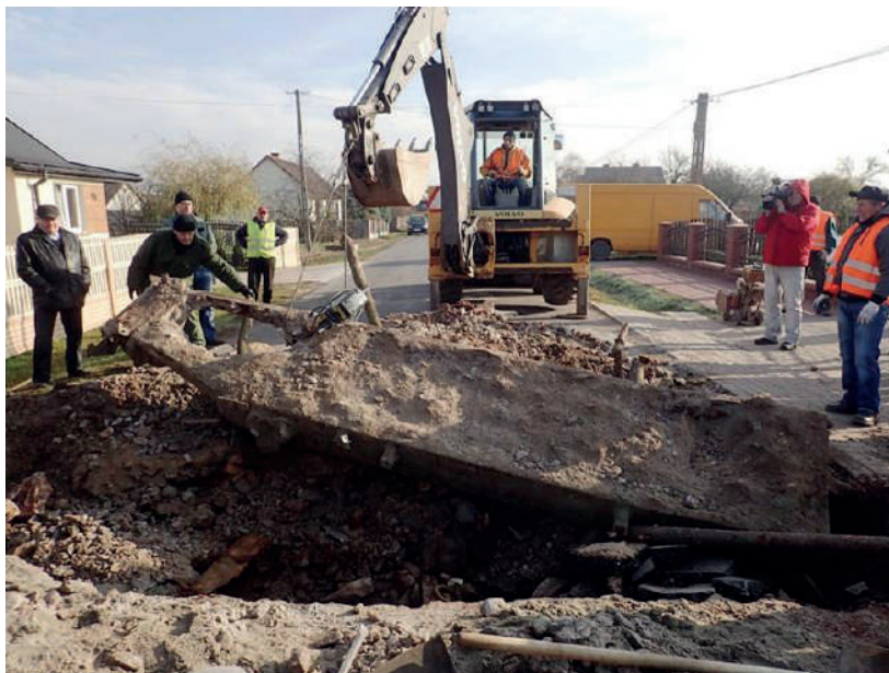
Il. 237 – Rama od niemieckiego transportera opancerzonego Sd.Kfz.251, po wojnie wykorzystana do wykonania mostka, Radomice 2016 r.
