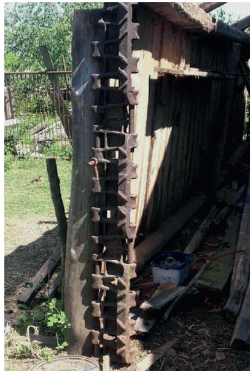
Il. 181 Filar podtrzymujący dach, wykonany z ogniów od czołgu Pantera, Brzeziny 2016 r.
