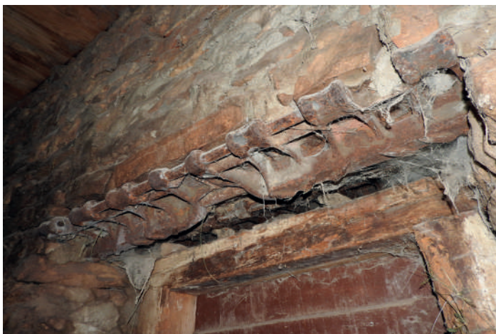
Il. 169 Ogniwa od czołgu Pantera wykorzystane jako nadproże, Radomice 2020 r.
