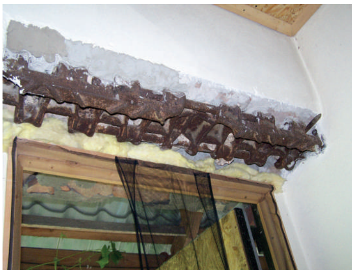
Il. 178 Ogniwa od czołgu Pantera wykorzystane jako nadproże, Radomice 2015 r.
