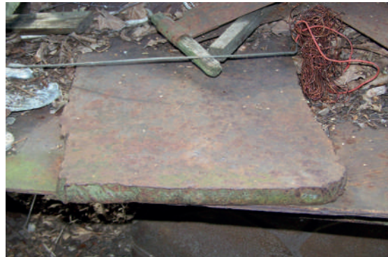
Il. 202 Element z czołgu T-34, wykorzystany jako nadproże, Lisów 2020 r.
