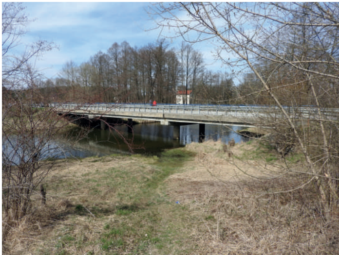
Il. 63 Miejsce budowy mostu na Czarnej Nidzie w Bieleckich Młynach przez saperów z 17. brygady, 2021 r.
