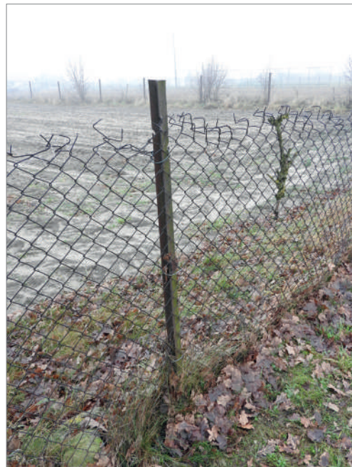
Il. 314 – Słupek do zaplatania drutu kolczastego w zasiekach, wykorzystany w płocie, Polichno 2021 r.
