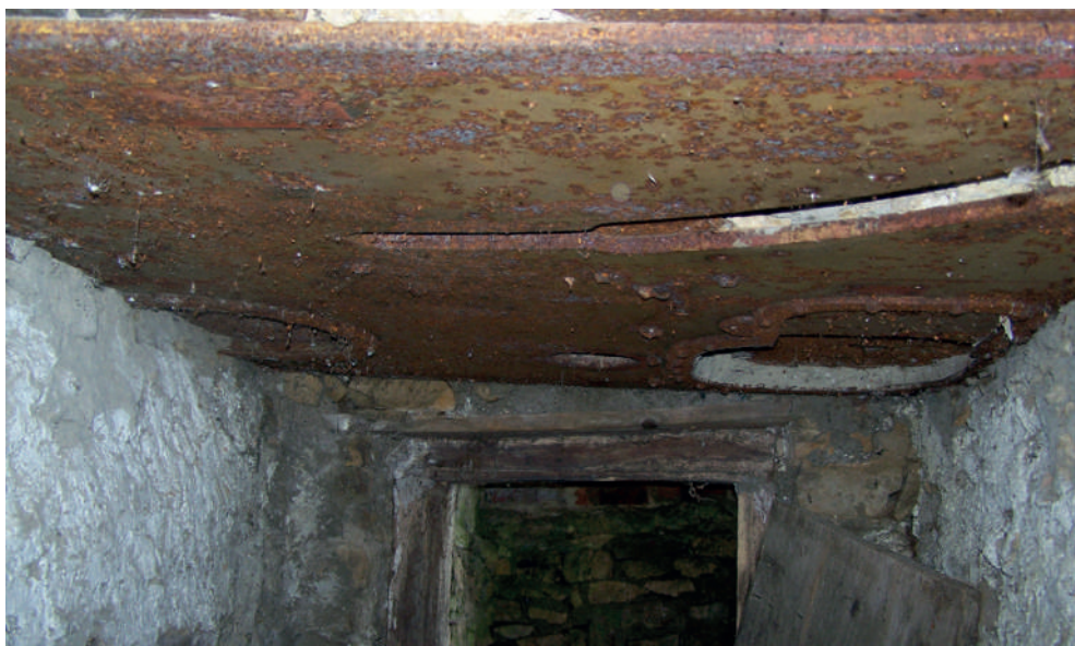
Il. 216 – Dach od niszczyiela czołgów Jagdpanzer IV, wykorzystany jako strop w piwnicy, 2013 r.
