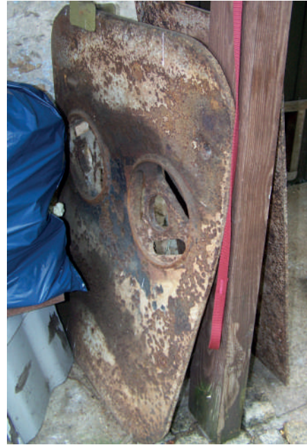
Il. 202 Element z czołgu T-34, wykorzystany jako nadproże, Lisów 2020 r.
