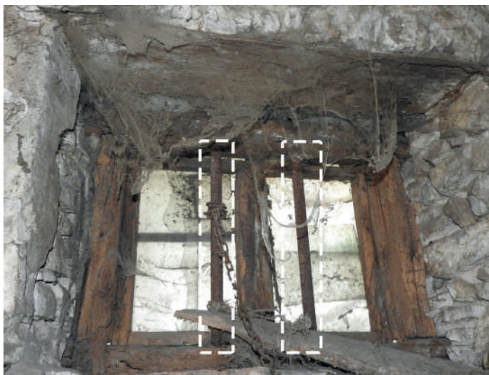
Il. 194 Szpilki od czołgu Tygrys I wykorzystane do zakratowania okna, Lisów 2020 r.
