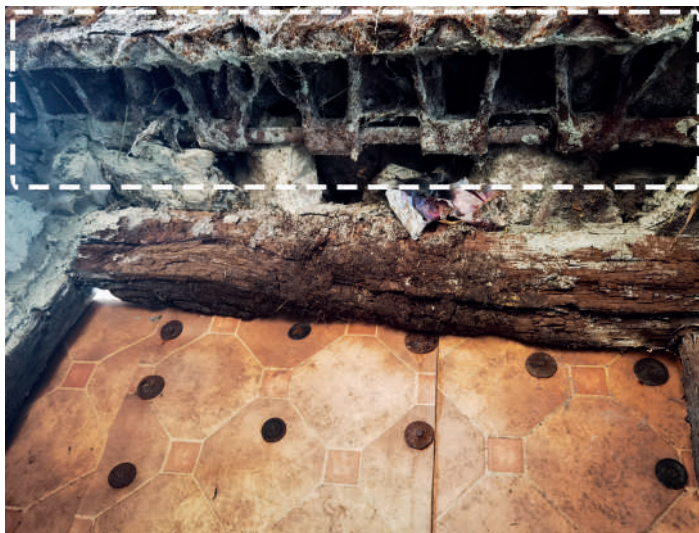
Il. 184 Ogniwa od czołgu PzKpfw IV wykorzystane jako nadproża, Lisów 2021 r.
