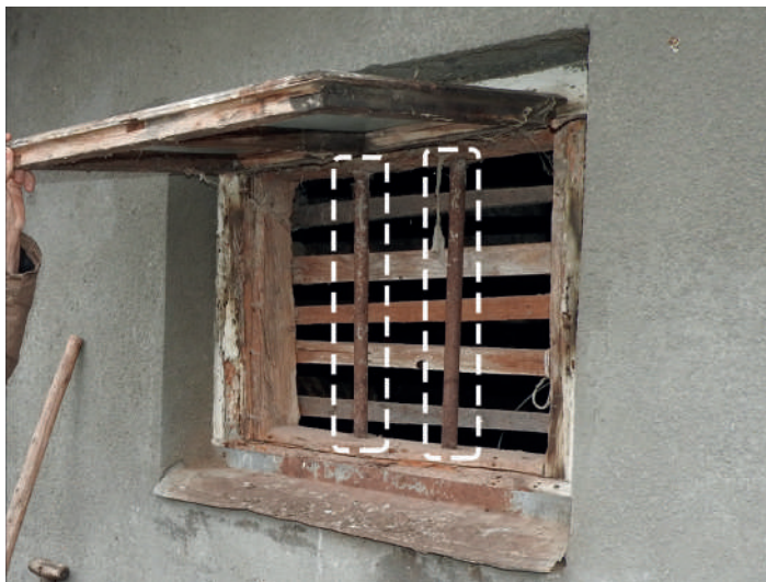
Il. 193 Szpilki do łączenia ogniów czołgu Pantera, użyte do zakratowania okna, Radomice 2021 r.
