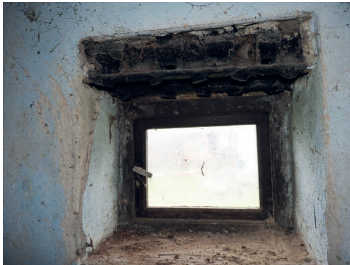
Il. 168 Ogniwo od czołgu Tygrys II, wbudowane w okno, Lisów 2020 r.
