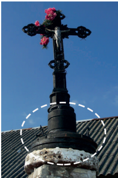
Il. 142 – Krzyż w czasie renowacji. Widoczny bęben hamulcowy i piasta z czołgu Tygrys, Obice 2014 r.
