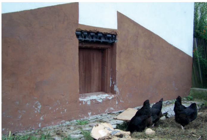
Il. 166 Ogniwo od czołgu Tygrys II wykorzystane jako nadproże, Lisów 2015 r.
