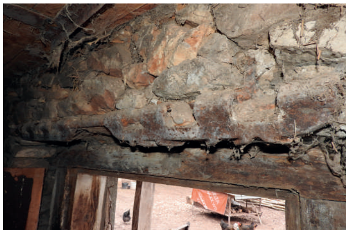
Il. 177 Ogniwa od czołgu Pantera wykorzystane jako nadproże, Radomice 2020 r.
