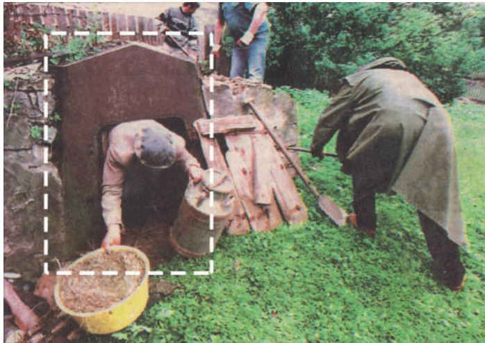
Il. 232 Przód transportera Sd.Kfz.250 wykorzystany do budowy piwnicy, Marzysz 1997 r.
