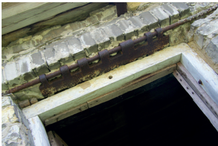
Il. 164 Ogniwo od niemieckiego czołgu Tygrys II, wykorzystane jako nadproże, Lisów 2014 r.
