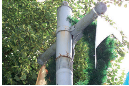
Il. 129 – Zwieńczenie krzyża. Widoczny gwint, na który nakręcano hamulec wylotowy z nałożoną łuską, Łąbedziów 2006 r.
