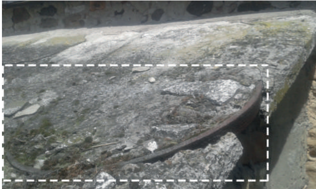
Il. 208 Element z koła od czołgu Pantera, jako wzmocnienie stropu, Radomice 2017 r.
